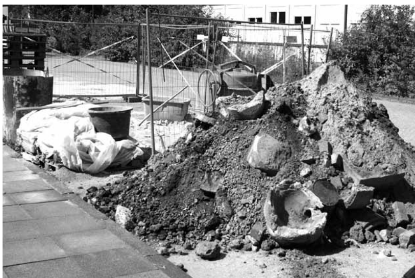
Zwischen der Hochschule Bochum und dem Gebäude ID gehen die Bauarbeiten weiter, auch auf Kosten der Umwelt.
