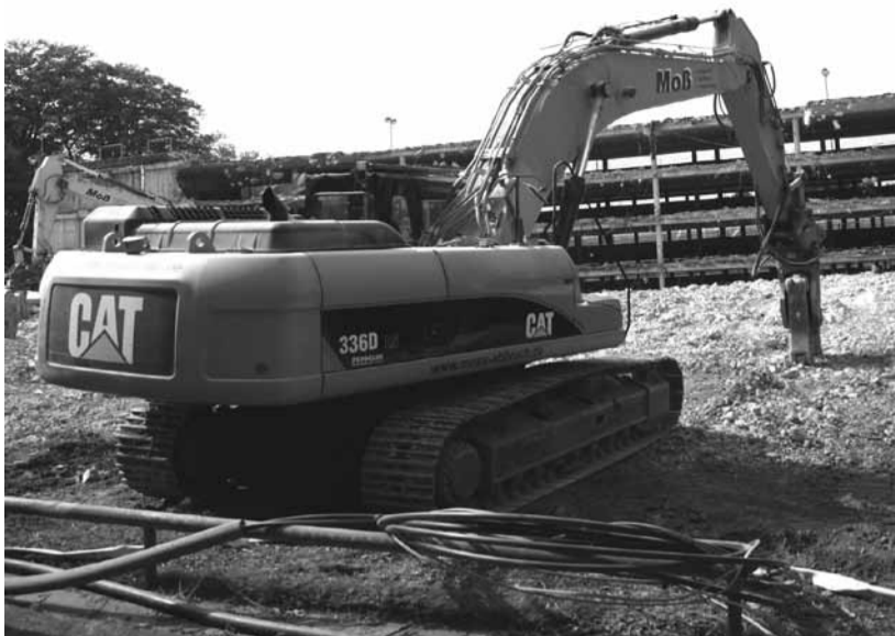
Im Westen was Neues: Das Parkhaus West ist bereits zur Hälfte abgerissen, nach dessen Sanierung folgt die Zweite. Foto: fik
