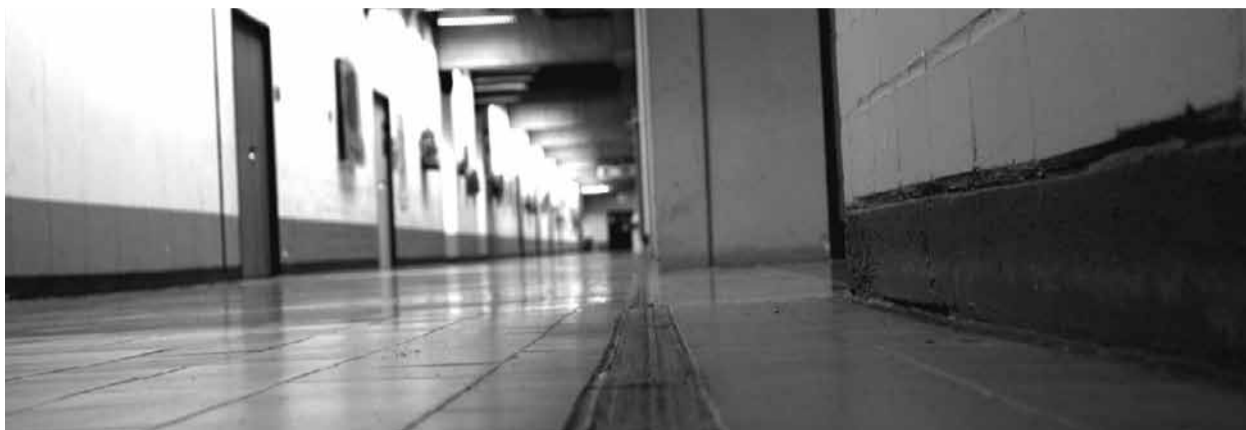
Die Flure der RUB bergen ungeahnte Gefahren: Die PCB-Werte im Fugenmaterial sind bedenklich hoch. Foto: mar
